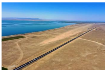
S21沙漠高速公路
